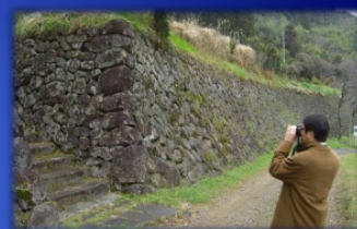
写真8-1 薩摩興業跡の石積み(野面積み)
