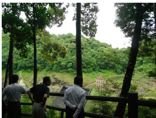
旧曾木発電所遺構
