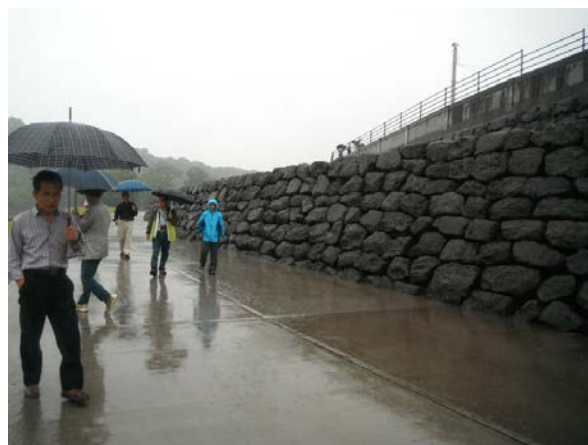
虎居激特事業で構築された石垣
