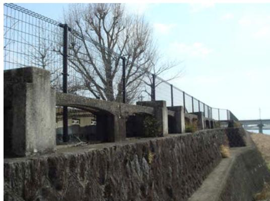
左の写真が現存している畠堤で、緩いカーブのついでパラペットに、畠を差し込むスリットがあり、台風による増水時に、近くの家から畠を持ち寄って、浸水を防いだと言われています。
